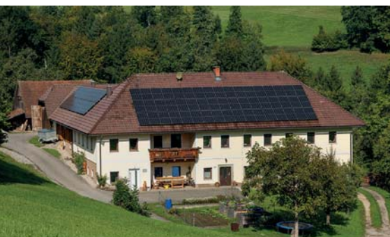
Am Reichlgut werden ca. 50 % der Stromkosten durch die PV-Anlage eingespart.
